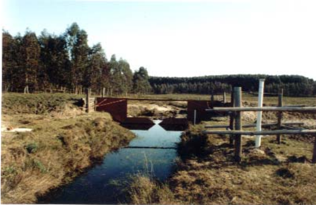
Figura 2. Vista, desde aguas arriba, del cierre ubicado en la microcuenca en monte forestal, constituido por un terraplén provisto con vertedero de lámina delgada, de tipo triangular-rectangular, en su zona central
